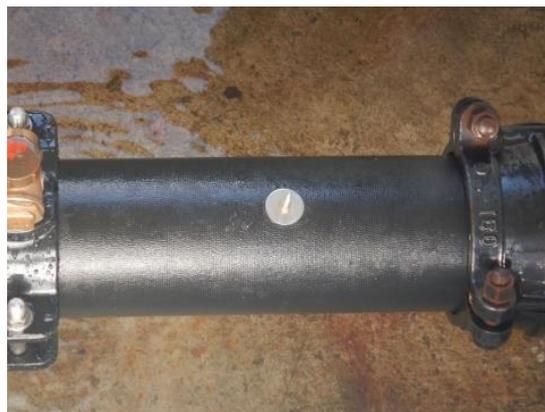
**写真-7 25mm 異形孔止水状況（有圧）**
