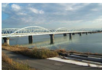
写真1 六十谷水管橋
