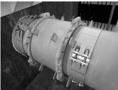
写真-1 事例1 (水管橋 SP600)
