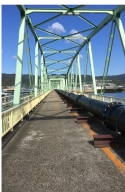
写真3 六十谷橋トラス部
