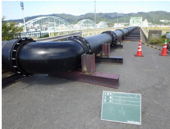
写真5 仮設配管布設状況
