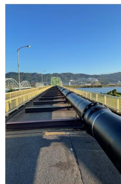
写真4 六十谷橋鉸桁部
