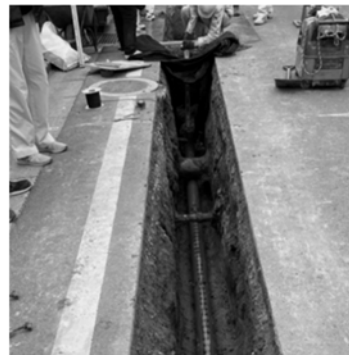
写真-1 試験施工
