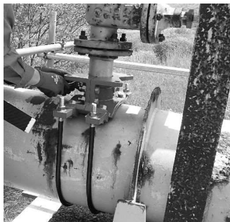
写真-3 作業状況
