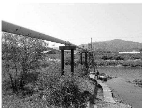
写真-1 現場状況
