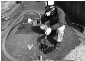
写真1 アイスビグ注入状況
