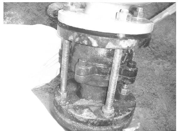
写真3 ステンスロングボルト補強工法
