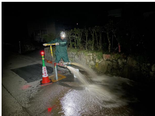
【夜間洗管排水の状況】
