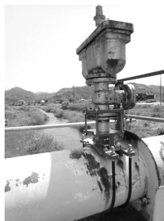
写真-4 施工完了
